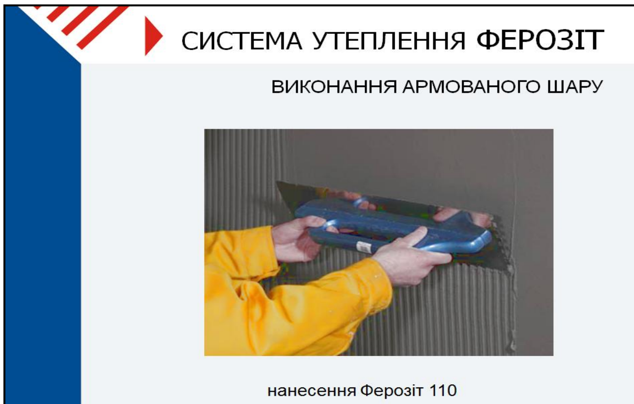
Рис. Д.3. Нанесення шару клею для арматурної сітки
