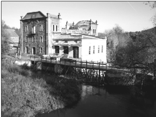
Рис. 6. Зруйнований млин, с. Сокілець
