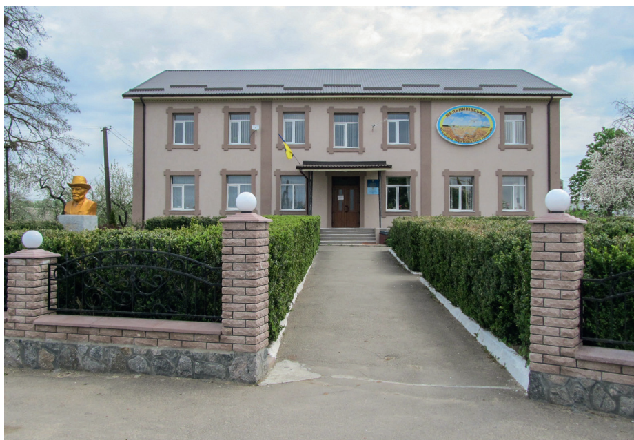
Приміщення Мельниківської об'єднаної територіальної громади
