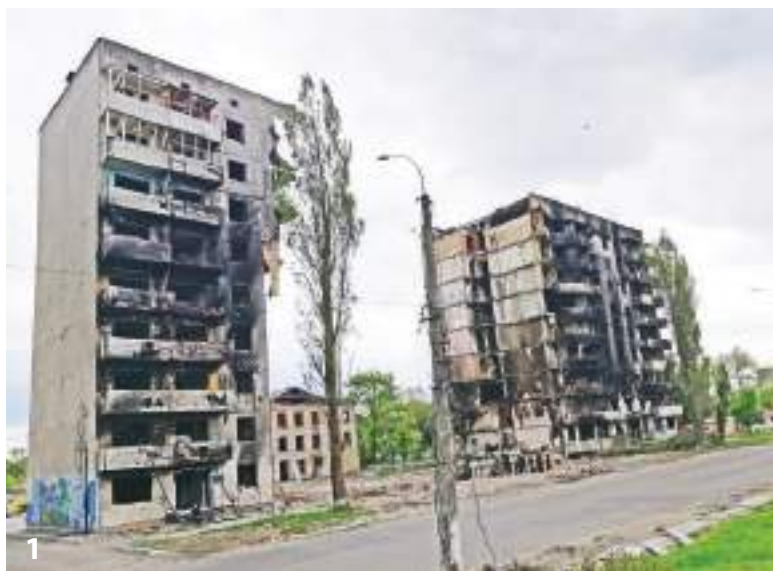
1. Зруйнований будинок. м. Бородянка Київської обл. Червень 2022 р. Світлина З. Куценко
