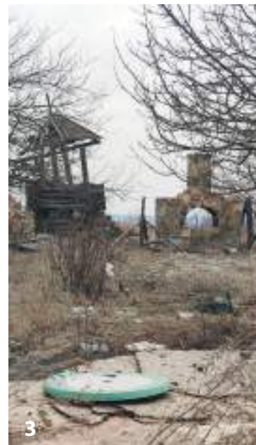
3. Зруйнована будівля. м. Ізюм Харківської обл. 2024 р. Світлина Ю. Комісарової
