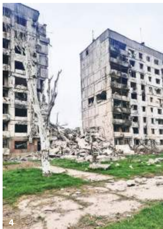
4. Руйнування багатоквартирного житлового будинку. м. Оріхів Запорізької обл. Березень 2024 р. Світлина В. Волошина
