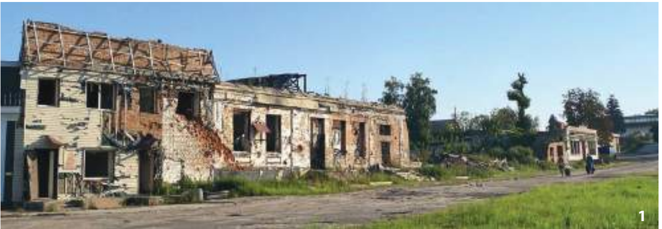
1. Торговельні будівлі на вокзальній площі, зруйновані під час бойових дій у лютому-березні 2022 р. м. Тростянець Сумської обл. 21 серпня 2023 р. Світлина Н. Литвинчук
