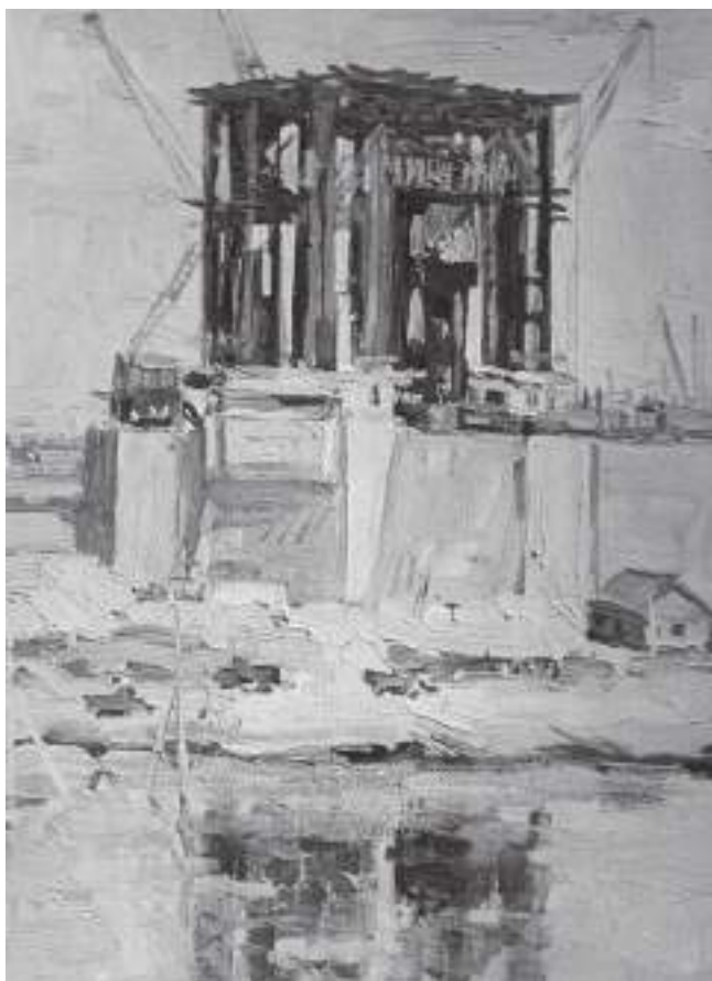
Н. Сиротенко. Будівництво Каховської ГЕС
