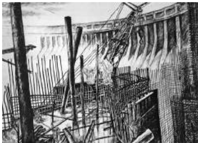
Ю. Мельниченко. Перед заливкою бетону. Туш, перо, вугільний олівець. 1973
