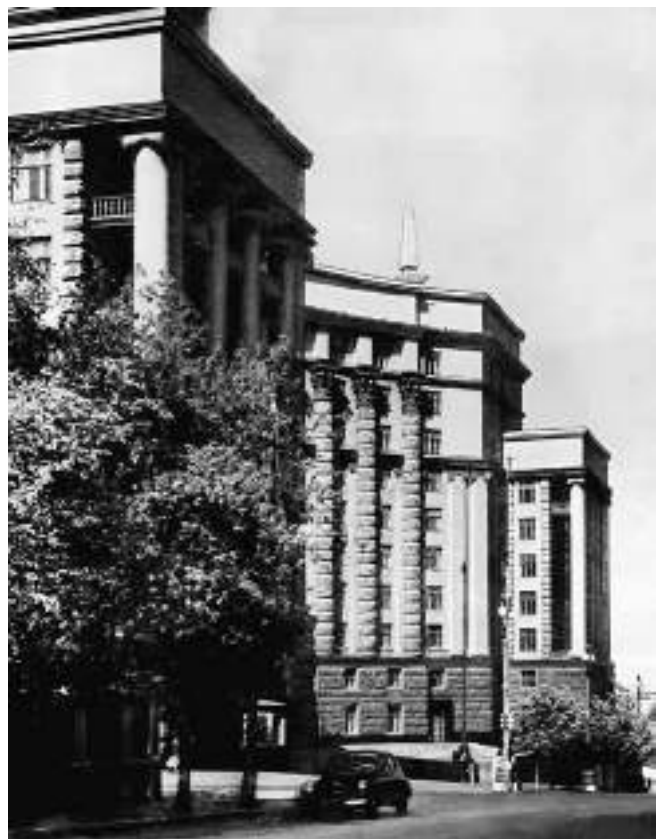
Архітектори І. Фомін, П. Абросімов. Будинок НКВС УРСР у Києві. 1935–1937
