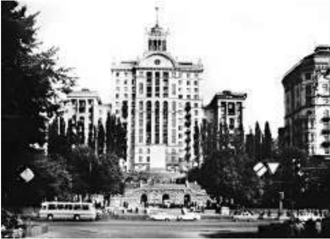
Архітектори О. Власов, А. Добровольський, О. Малиновський, В. Єлізаров, Б. Приймак, О. Заваров та ін. Забудова Хрещатика в Києві. 1951–1956
