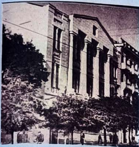
Будівля ампірної міської Думи 1911 р. Автор фото невідомий.
