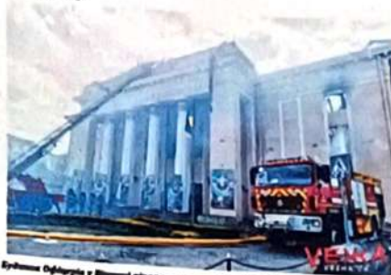
Будівля Офіцерів у Вінниці після російського обстрілу 14 липня 2022р. РЕЖА.
