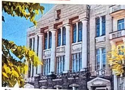
Будівля ампірної міської Думи. 2024 р. Автор Діана Кутіпір.
