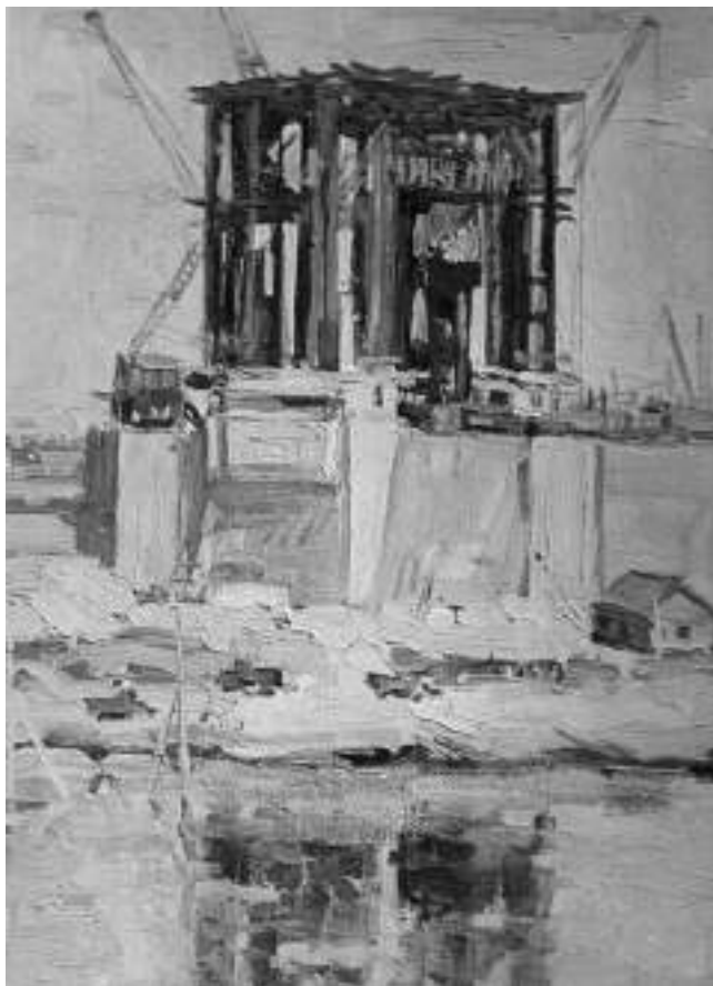
Н. Сиротенко. Будівництво Каховської ГЕС
