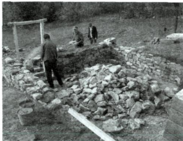
Рис. 50. Будівництво бані на садибі Гладкого В.М., с. Буша
